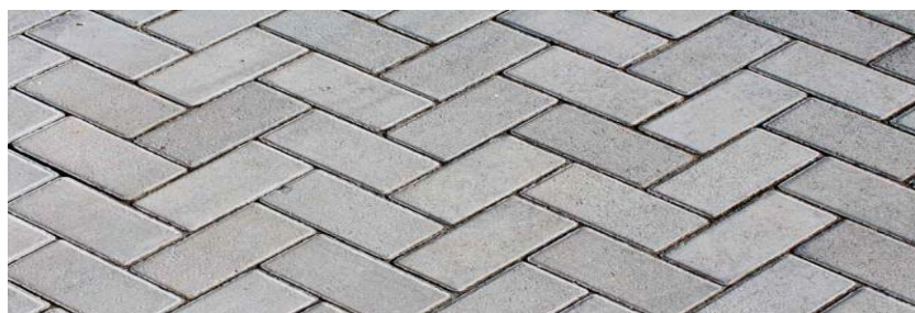
Figura 28: Pavimentação permeável
