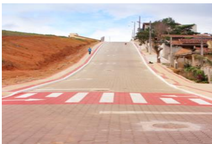
Figura 20: Pavimentação e infraestrutura do Itaputera
